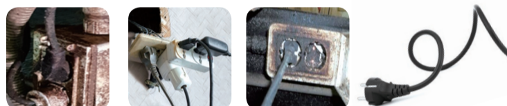
용량 초과인 문어발식 콘센트 사용과 느슨하게 연결된 플러그는 화재의 원인이 됩니다.
